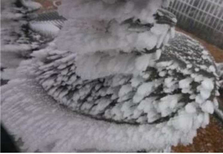
Şekil 1. İzolatör üzerinde kuru büyüme buzlanması
