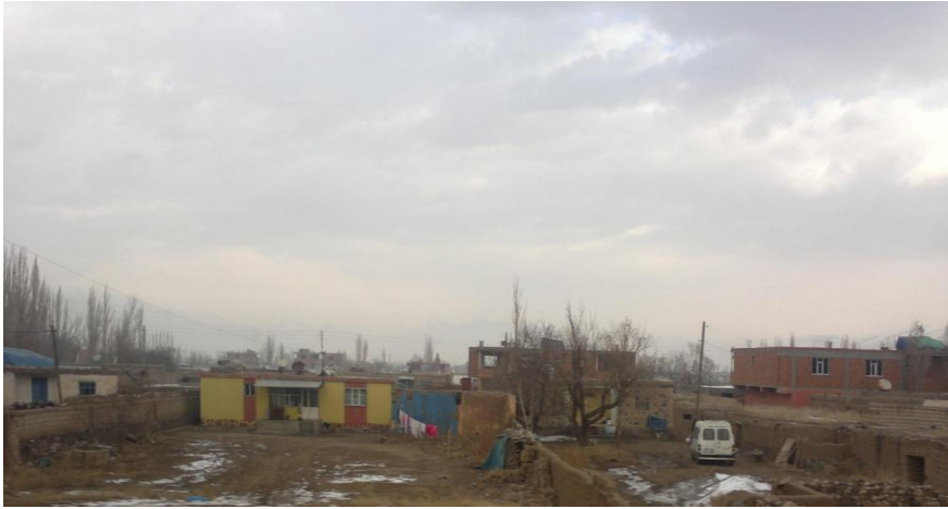
Foto 71: Tek Katlı Evlerin Yoğun Bulunduğu Yeni Mahalle'den Bir Görünüm
