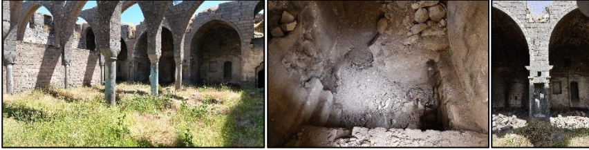
Şekil 21 Kilise Naos bölümü ve yapı içinde yapılan kaçak kazılar
