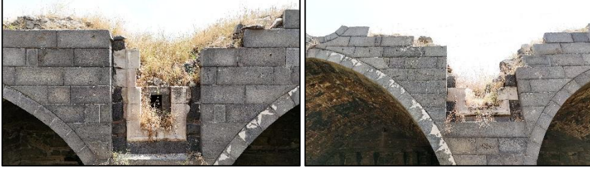
Şekil 14 Apsis cephesi yüzey kaybına uğrayan motifler
