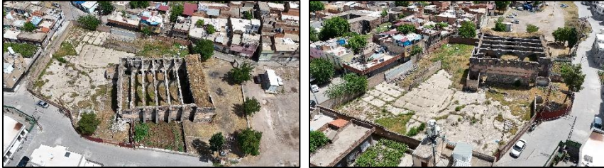
Şekil 2 Kilise yapısı hava fotoğrafı- 2025
