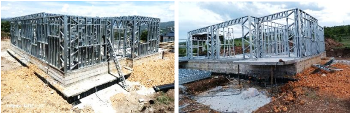
Şekil 12. Diyarbakır 'da Hafif Çelik Yapı Örneği (Bekçi, 2025)
