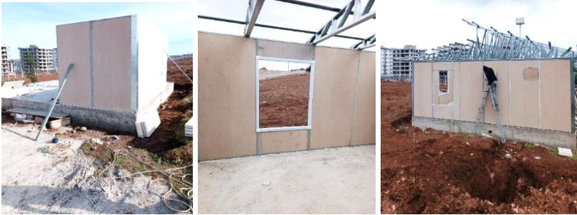
Şekil 6 Pres panellerin bir araya getirilerek kurulması (Bekçi, 2025)
