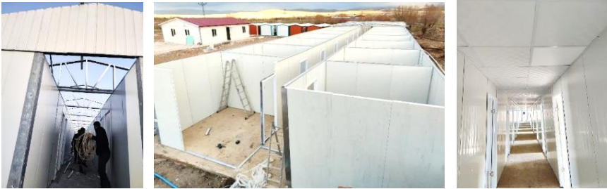
Şekil 7 Şantiyede sandviç panel sistemle yatakhane yapılması (Bekçi, 2025).
