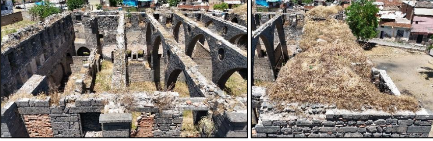
Şekil 12 Yağmur suyu etkisi ile oluşan bitkisel oluşumlar
