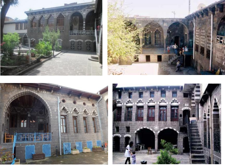
Şekil 8 Diyarbakır Geleneksel Evi Eyvan Örnekleri (Aykal Arşivi, 2002)
