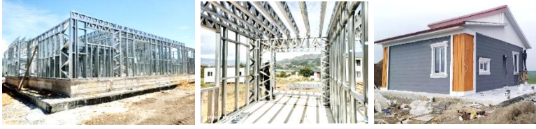
Şekil 17. Diyarbakır Kulp'ta Hafif Çelik Konut Örneği (Bekçi, 2025)
