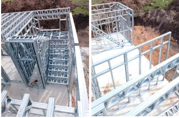
Şekil 8 Hafif çelik sistemle konut inşa edilmesi (Bekçi, 2025)
