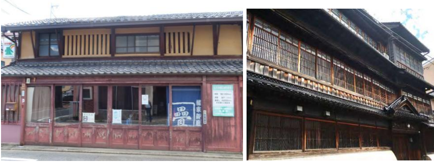
Şekil 13 (a) Shinkabe Örneği (Dawson, 2025)(b) Kōshi Örneği (Kotrc, 2020)
