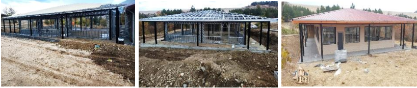
Şekil 16. Diyarbakır Dicle Gençlik Spor Hafif Çelik Yemekhane Örneği (Bekçi, 2025)
