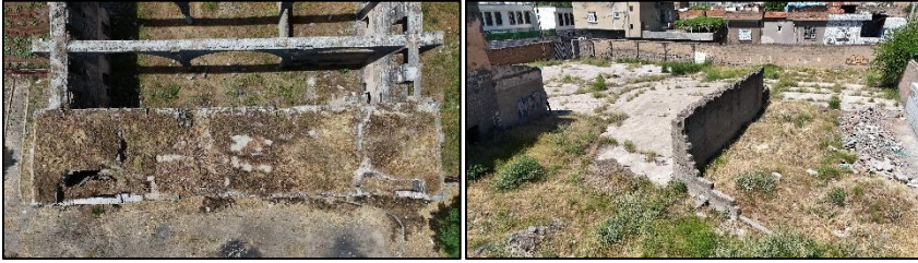
Şekil 18 Yapı çatısında ve avlusunda beton şap
