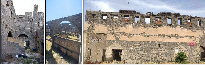
Şekil 20 Eklenti duvar ve kapatılan kemer boşlukları
