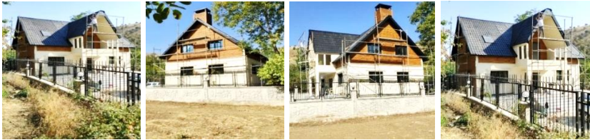
Şekil 14. Diyarbakır Çüngüş'te Hafif Çelik Konut Örneği (Bekçi, 2025)
