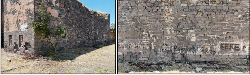
Şekil 16 Yapı doğu cephesinde oluşan derz kayıpları
