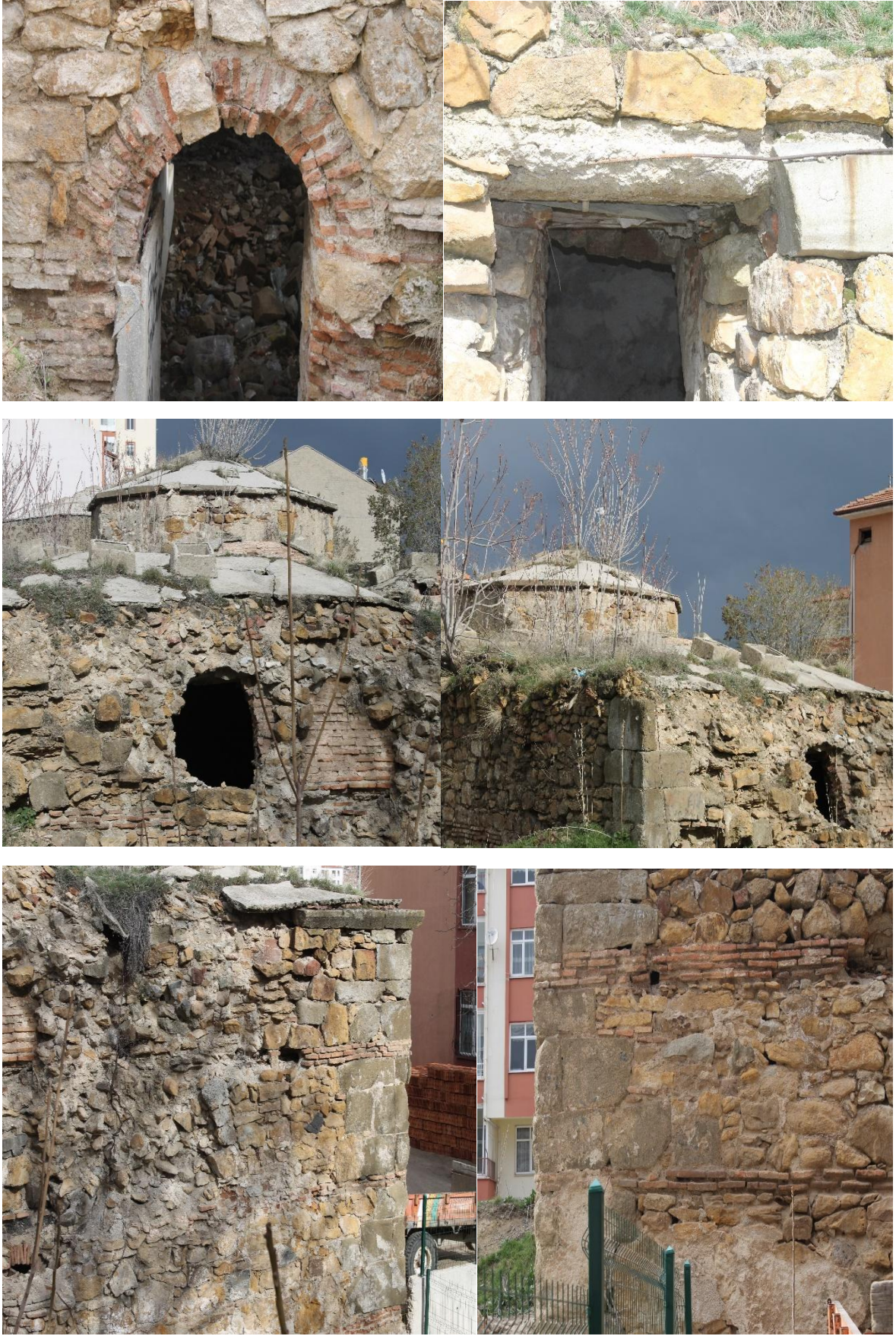
Şekil 12. Yozgat Başçavuş Hamamı – Dış Görünüřler (Fotoğraflar Yazara Aittir.)
