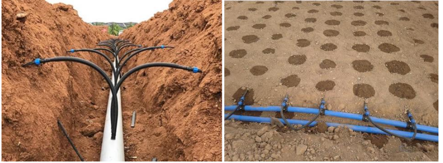
Şekil 5. Yer altı sulama yöntemi
