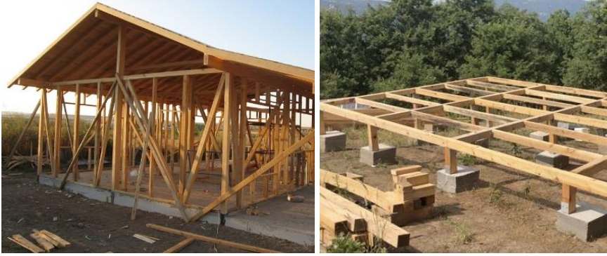
Şekil 8. Betonarme temel üzerine ahşap ev uygulaması (Kuloğlu, 2024)
