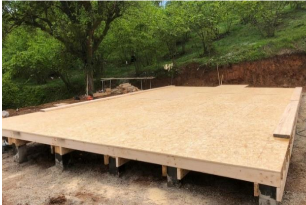
Şekil 9. Ahşap ev yapımında temel için kullanılan kalaslara örnek (Woodlife, 2024)
