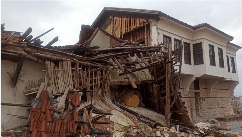
 ekil 10. Kahramanmaraş il merkezinde, depreminde yıkılan (sol) ve ayakta kalan (sağı) ahşap evlere  rnek (Yesilafsin, 2024).
