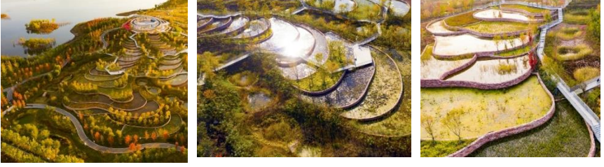
Şekil 8. Handan Atıksu Arıtma Tesisleri.
