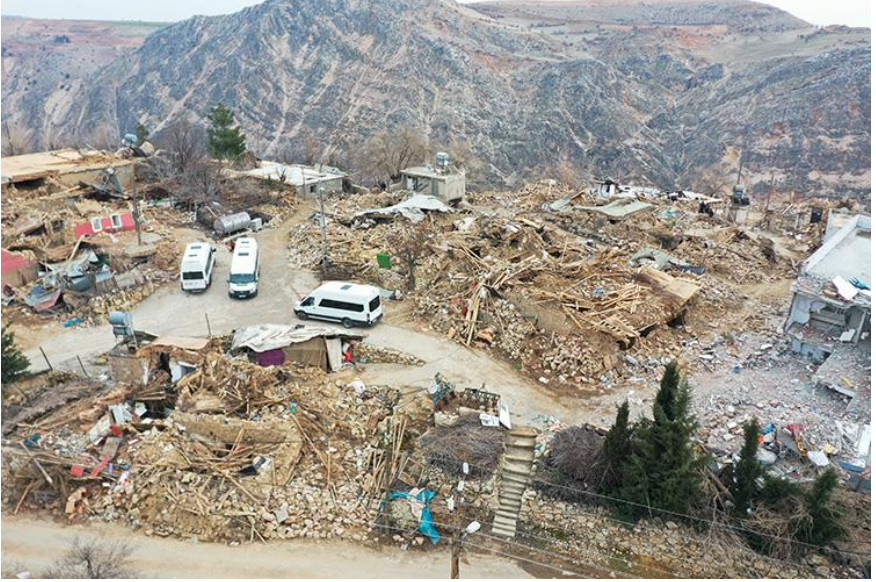
Şekil 11. 2023 Kahramanmaraş depremi etkisi ile Adıyaman ilinde yıkılan kerpiç/taş örme tipi evlere örnek (İlhan, 2024).
