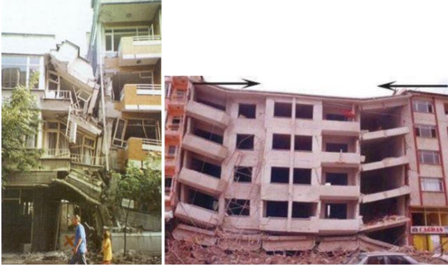
Resim 10 Çekiçleme Etkisi Hasarları
