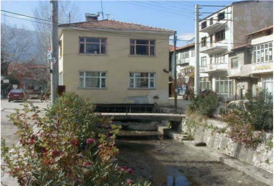
Resim 5 Dere yatağının üzerinin kapatılarak konut, otopark, pazar yeri yapmak amacıyla kullanılması.
