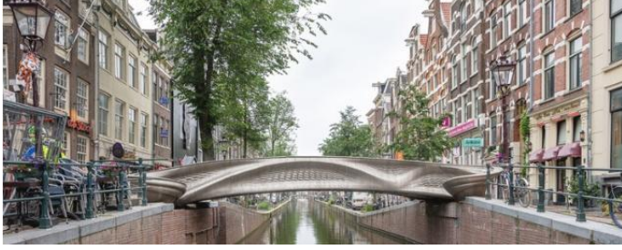
Şekil 5 3D yazıcı teknolojisinden yararlanılarak yapılan çelik köprü
