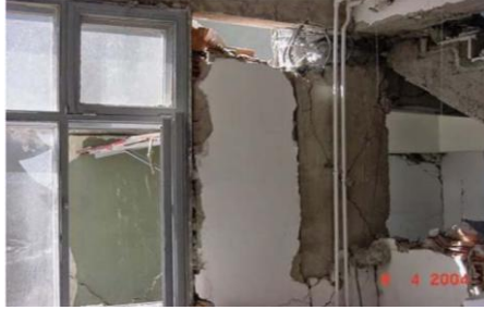
Resim 3 Kolonda Basınç Hasarı
