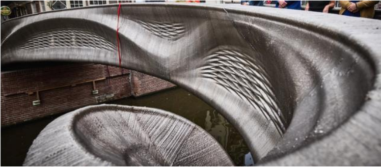
Şekil 6 3D yazıcı teknolojisinden yararlanılarak yapılan çelik köprü
