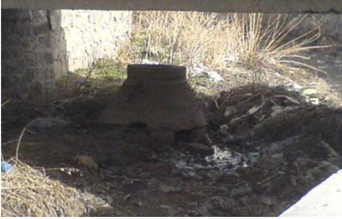
Resim 4 Dere yatağına kanalizasyon şebekesi döşenmesi
