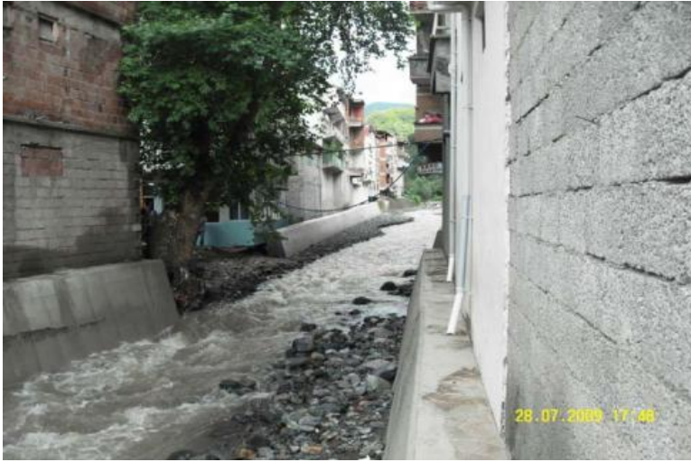
Resim 1 Yapılan yapılaşma ile kesitin daraltılması
