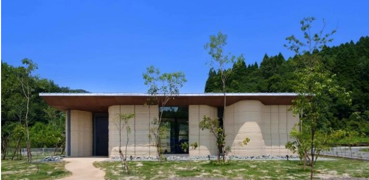
Şekil 13 3D baskı ile üretilmiş ev yapısı
