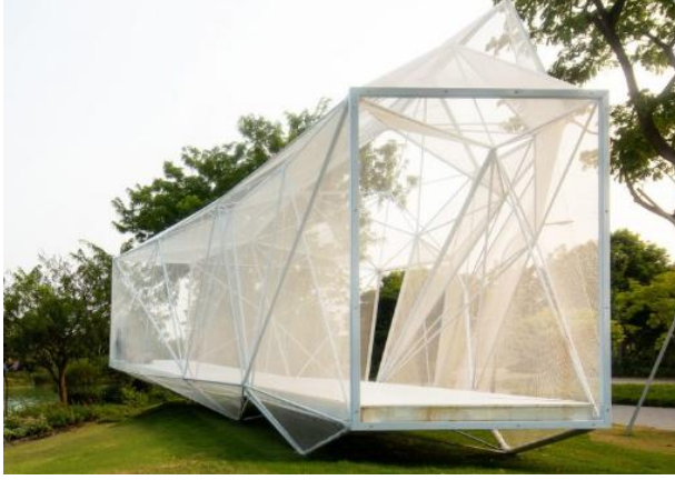
Şekil 7 3D baskı ile üretilmiş, AirMesh yapısının görünümü
