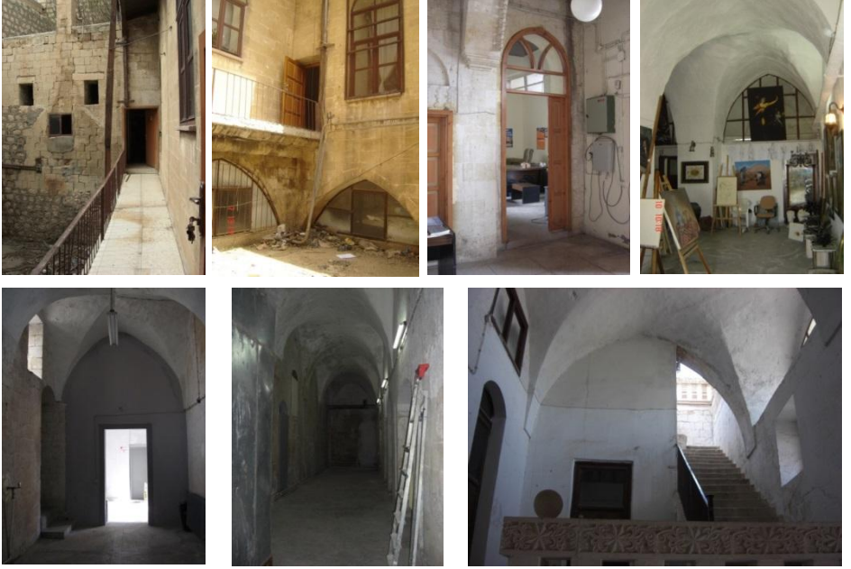
Şekil 12. Yapının İç Mekân Görünümleri, 2009
