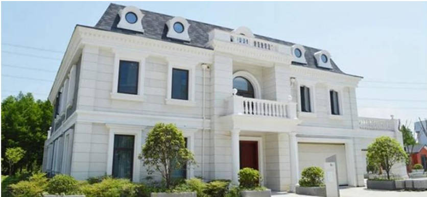
Resim 12 Winsun Firması Tarafından 3D Yazıcı İle Üretilmiş Villa
