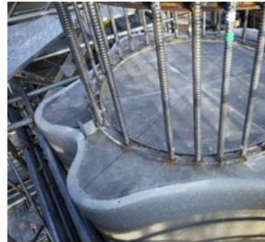
Resim 10 3D Yazıcı Teknolojisiyle Taç Yapağı Şeklinde Kolon
