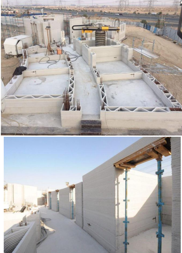
Resim 11 Dubai’de Üretilen Bir Ofis Yapısının İnşası
