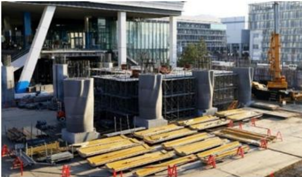
Resim 10 3D Yazıcı Teknolojisiyle Taç Yapağı Şeklinde Kolon
