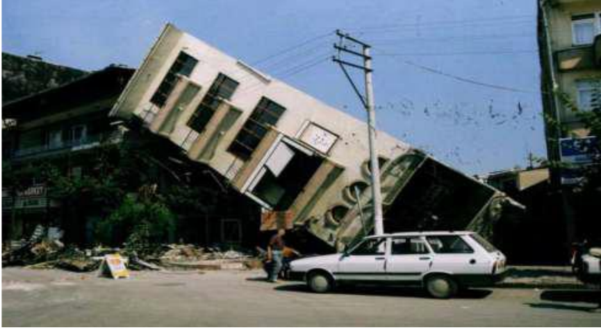
Şekil 13 1999 Adapazarı depreminde sıvılaşma sonucu binanın devrilmesi
