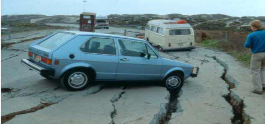
Şekil 10 Loma Prieta depreminde devlet parkı yakınında oluşan yanal yayılmalar sonucu oluşan deformasyonlar
