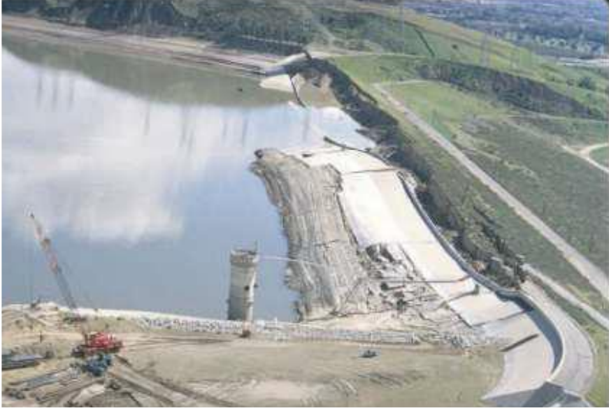
Şekil 9 1971 San Fernando depreminde Lower San Fernando barajında oluşan akma sıvılaşması
