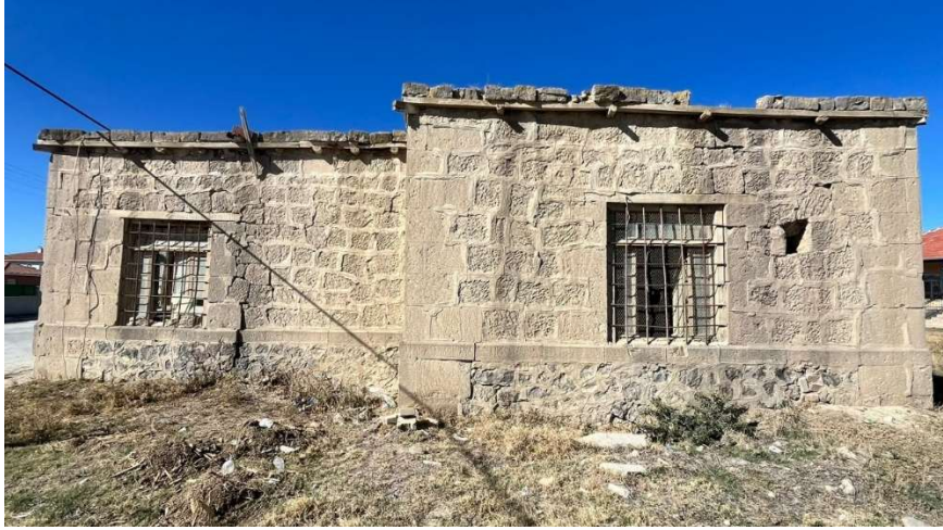
Şekil 11. H-TASD Evi Doğu cephesi
