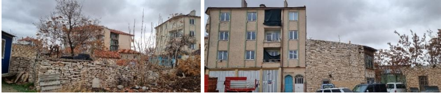
Şekil 9. Doku ile uyumsuz betonarme yapılar
