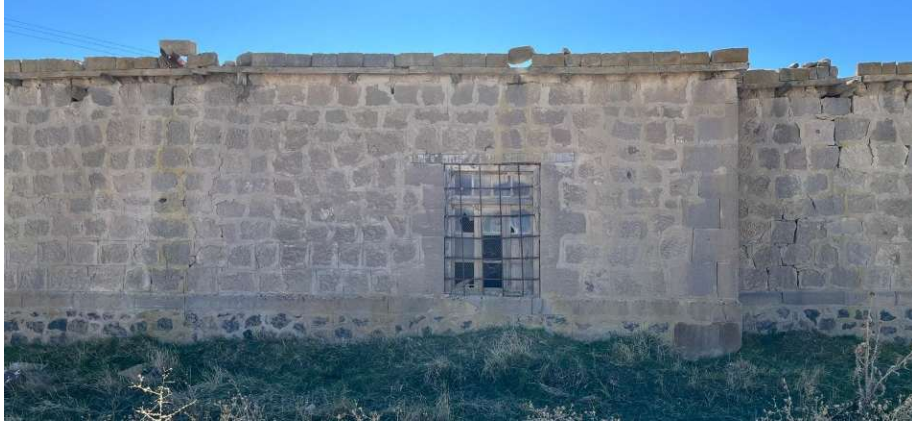
Şekil 13. H-TASD Evi kuzey cephesi
