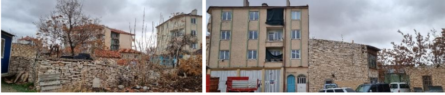
Şekil 9. Doku ile uyumsuz betonarme yapılar
