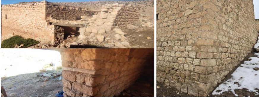
Şekil 8-9: Yıęma taş yapı duvar rnekleri
