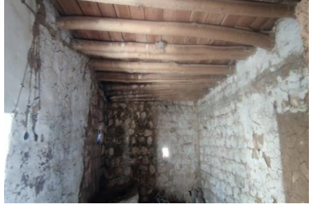
Şekil 10. Kerpiç malzeme iç duvar ve Ahşap Kiriş-beş
