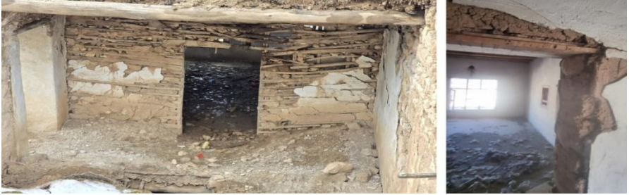
Şekil 12-13. Briket iç duvar
