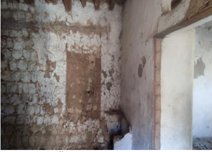
Şekil 10. Kerpiç malzeme iç duvar ve Ahşap Kiriş-beş
