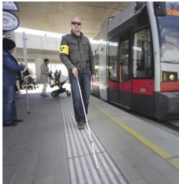
Resim 23 Görme engellilerin yön bulmasını kolaylaştıran hissedilebilir yüzey uygulamaları
