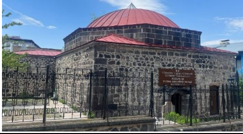
Dış Cephe Görşeli
