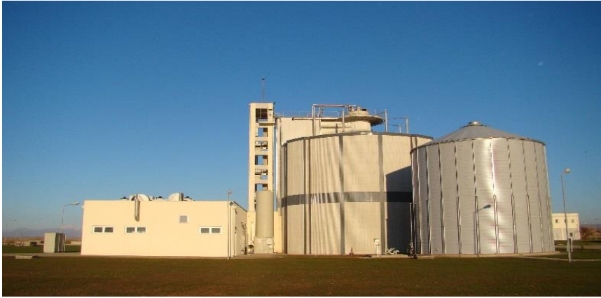
Şekil 9. Çamur Çürütücü Tankı
