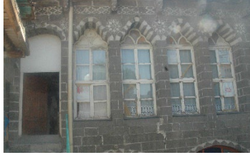
řekil 27-163 ada 12 parsel
