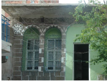
řekil 44-421 ada 15 parsel
