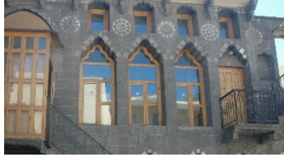
řekil 43-407 ada 3-4 parsel
