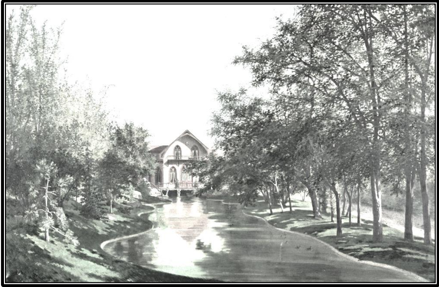
Şekil 8. Yıldız Sarayı bahçesindeki Kaskad Kasrı
