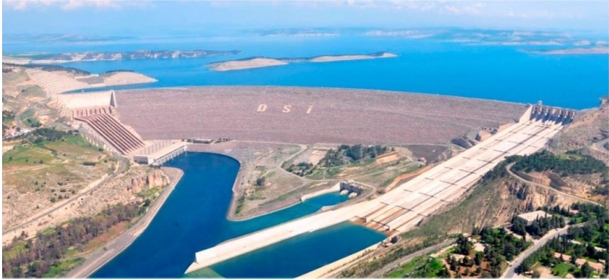
Foto 6. Atatürk Barajı ve Baraj Gölü
