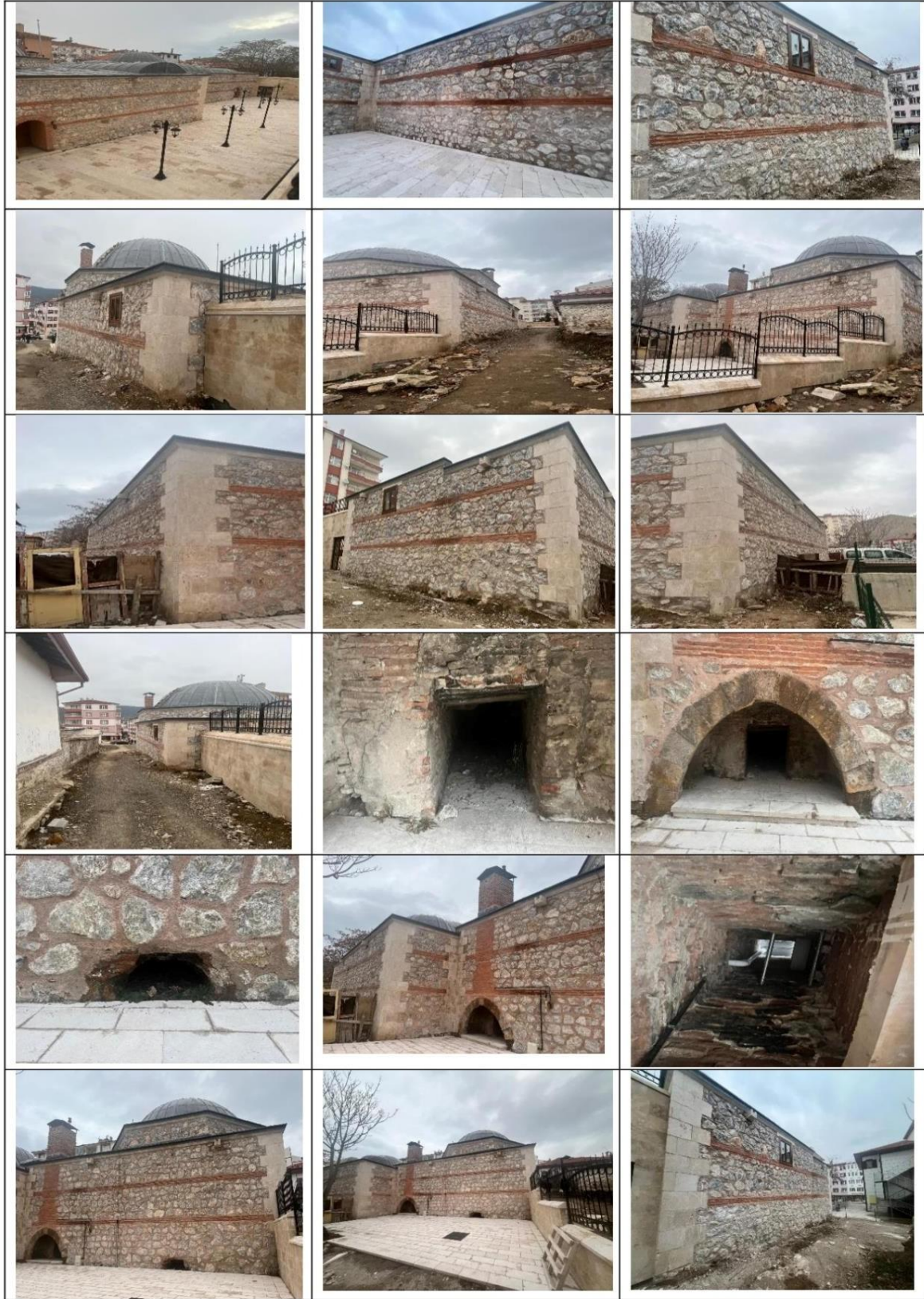
Ek-15. Yozgat Başçavuş Hamamı Restorasyon Sonrası Görselleri (Dış Görünüş),
