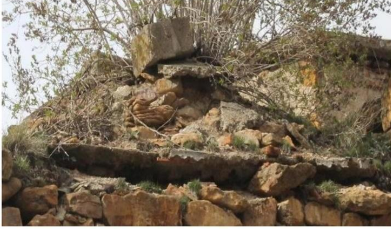
Ek-10. Yozgat Başçavuş Hamamı Kadınlar Bölümü Üst Örtü-Duvar
