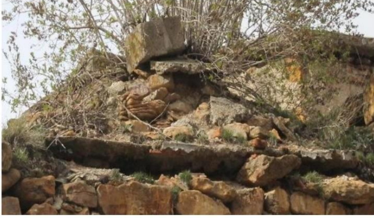
Ek-10. Yozgat Bařcavuş Hamamı Kadınlar Bölümü Üst Örtü-Duvar
