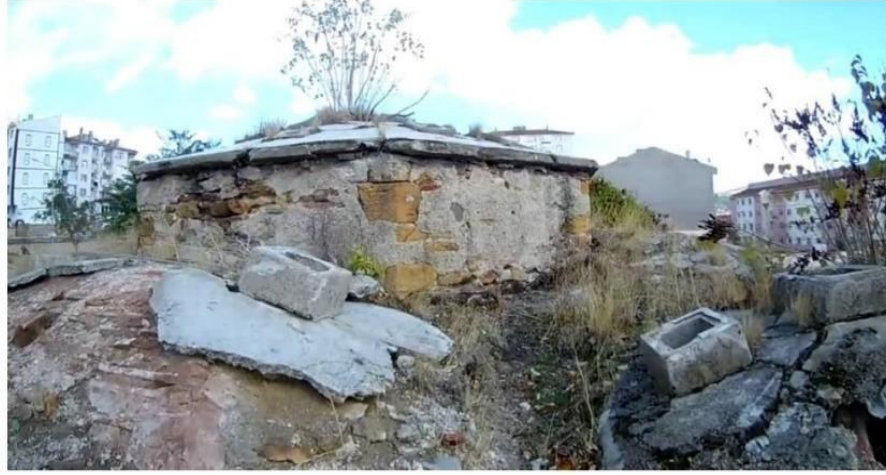
Ek-13. Yozgat Başçavuş Hamamı Dışından Üst Örtü-Erkekler Bölümü
