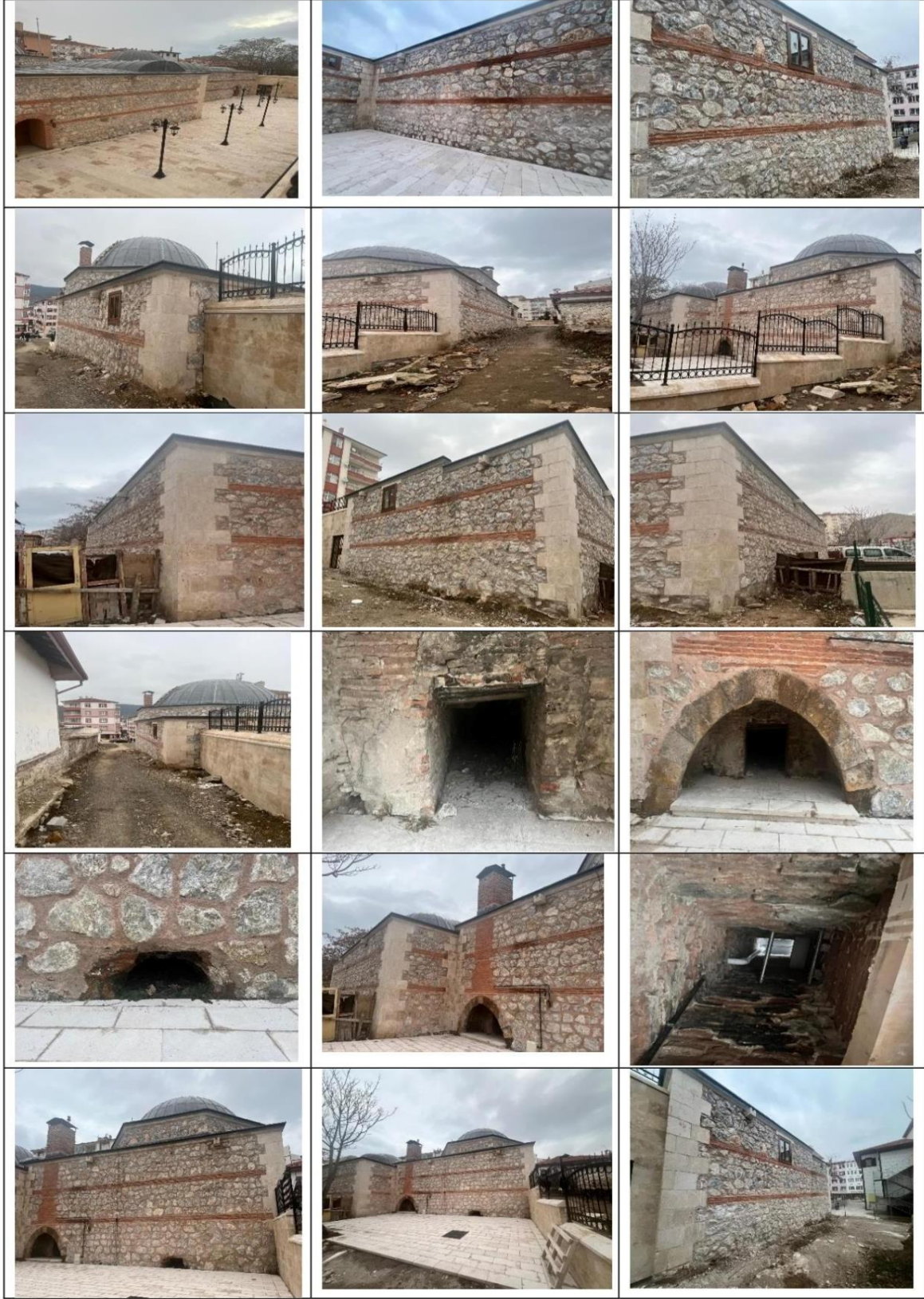
Ek-15. Yozgat Başçavuş Hamamı Restorasyon Sonrası Görselleri (Dış Görünüő),
