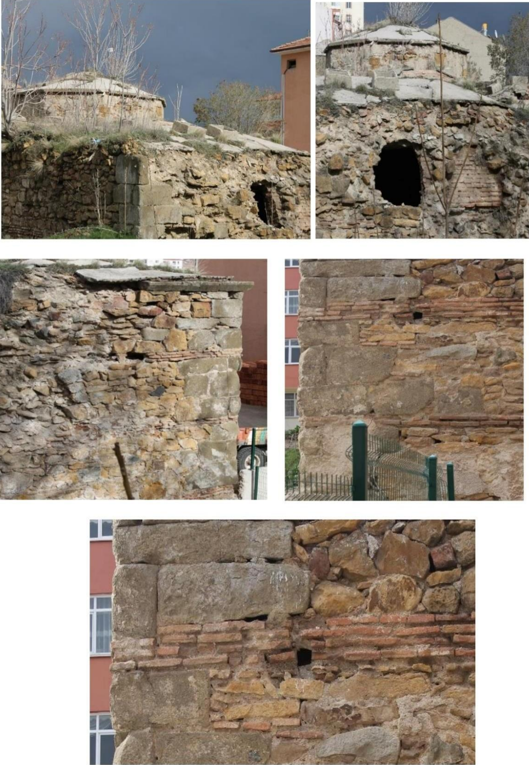
Ek-14. Yozgat Başçavuş Hamamı Dışından- Kadınlar Bölümü Giriş Yönü
