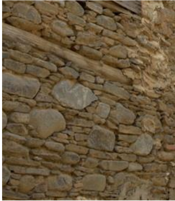
Resim 4.11. Kayrak Taşı Duvar Örgüsü
