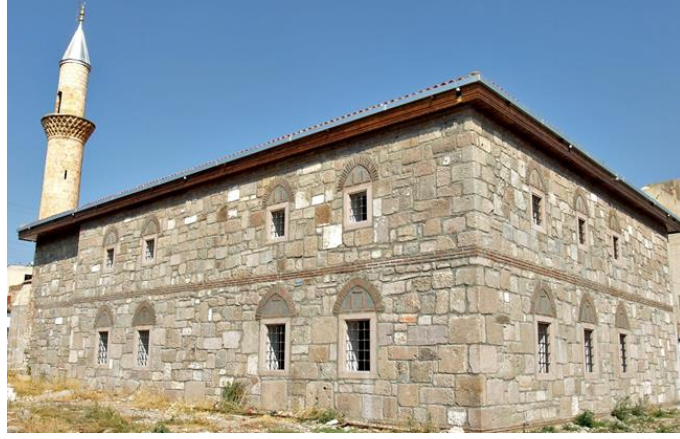
Resim 5.8. Bergama Emir Sultan Camii Rekonstrüksiyon Sonrası
