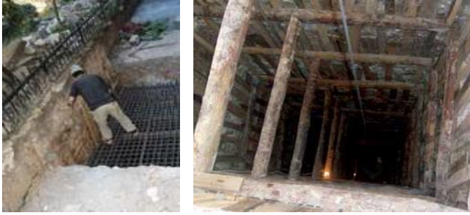
Şekil 6. Edirnekapı Mihrimah Sultan Camisinin zemininin sağlamlaştırılmasına yönelik kuyu temel yapım çalışmalarından görüntümler (Sesigür & Çalı, 2014).
