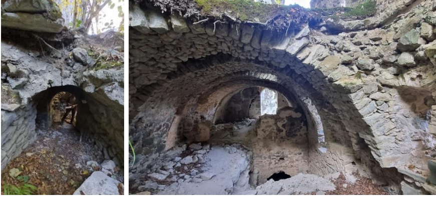
Şekil 30. Manastırın İdari binasının avlu ile bağlantısını sağlayan koridor (soda) ile üst kat odalarından (sağda) görünümüler (Çolak Muşmul & Engin, 2024).
