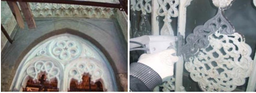
Şekil 11. Pertevniyal Valide Sultan Camisi restorasyonu esnasında, mermer yaşmaklarda yapılan kimyasal temizlik (solda) ve dökme demir yaşmaklarında kumlama yöntemi ile temizlik (sağda) çalışmalarından görünümeler (Çebi, 2010).
