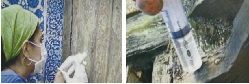
Şekil 8. Yeni Cami Hünkar Kasrı 'nda enjeksiyon yöntemiyle ahşap sağlamaştırma çalışmalarından görünüm (Zakar & Eyüpgiller, 2015).
