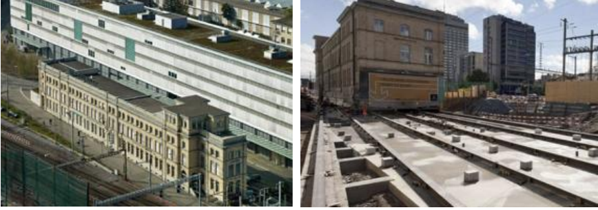
Şekil 12. İsviçrenin Zürih kentinde, makina, silah ve lokomotif üretimi yapılan yapının bütünlüğü bozulmadan taşınma sürecinden görünümeler (IBTimes, t.y.)
