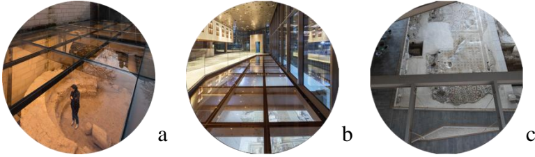
Şekil 52. Çelik teraslama için benzer uygulama örnek fotoğrafları (a) İstanbul'da Beyazıt kent kütüphanesi (Dörter, t.y.), (b)(c) Antakya'da The Museum Hotel (EAA, t.y.)
