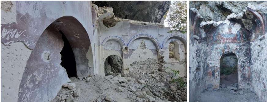
Şekil 39. Manastır kilisesi (solda) ve Şapelin sağlamlaştırılması gereken duvarları (Çolak Muşmul & Engin, 2024).
