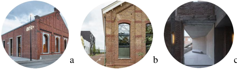
Şekil 45. Kapı ve pencere bütünlemeleri için benzer uygulama örnekleri; (a) Allts, Belçika'da eski dokuma fabrikası (Sterck, t.y.), (b) Utrecht, Hollanda'da eski demiryolu demir üretim atölyesi (Damme, t.y.), (c) Pekin, Çin'deki eski tren deposu (Zhu, t.y.)
