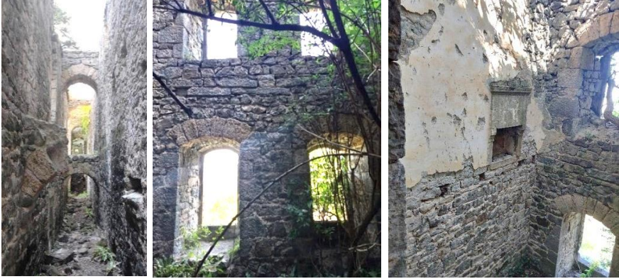
Şekil 38. Keşiş hücreleri ve misafirhane binasında sağlamlaştırılması gereken koridor duvarları (solda) ile odaların dış (ortada) ve iç (sağda) duvarları (Çolak Muşmul, 2022).
