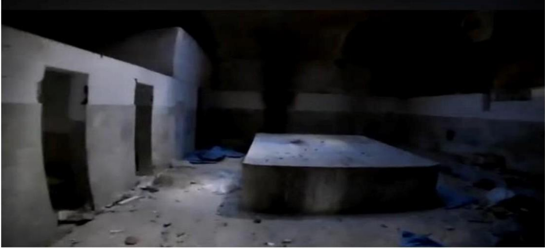
Ek-4. Yozgat Başçavuş Hamamı İç Mekanı- Erkekler Bölümü
