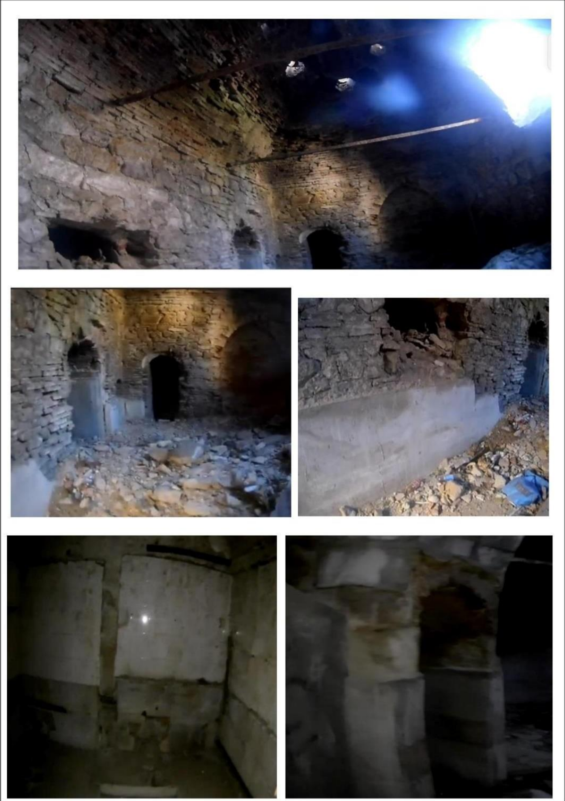
Ek-2. Yozgat Başçavuş Hamamı İç Mekanı-Kadınlar Bölümü
