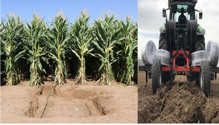
Şekil 8. Toprak altı damla sulama yöntemiyle sulanan mısır bitkileri, toprak altına döşenmiş lateraller ve laterallerin döşenmesi
