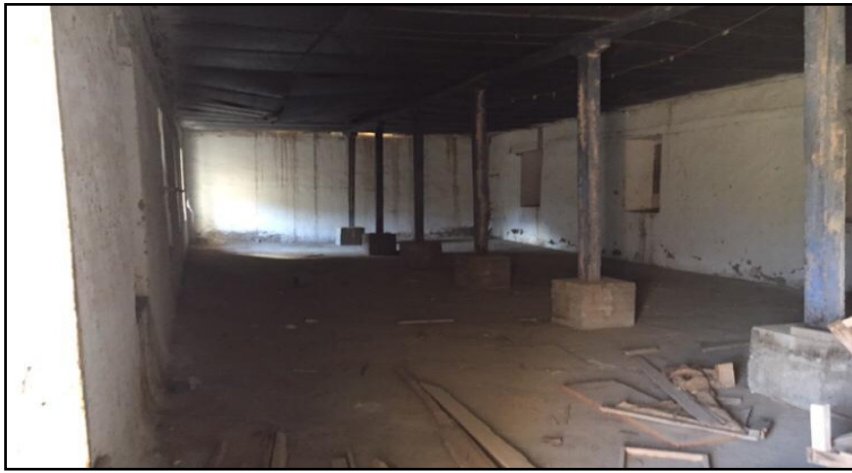
Depo binasının içerden görünüşü
