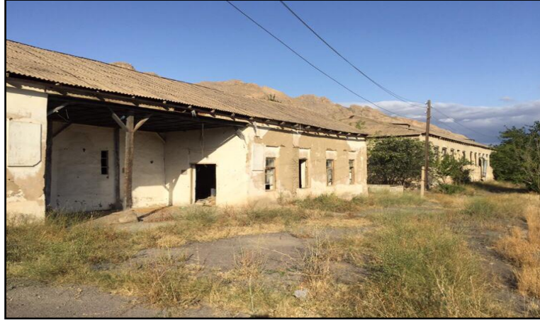
Ordubad İpek Koza Fabrikası ana binalarının görünüşü
