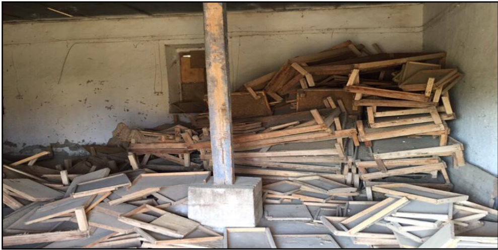
Depo binasının içerisindeki koza kutuları
