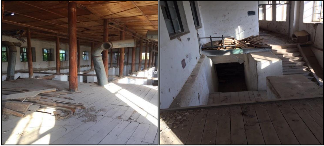
Fabrika merkez binası ve ana bina 1. kat girişi 2. katının görünüşü
