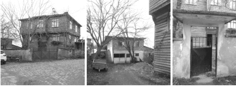
řekil 7 SH evi ve fındık iřileri iin  retilmiř betonarme ek yapı
