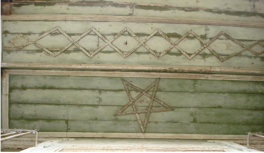
Şekil 3. Ahşap tavan kaplaması
