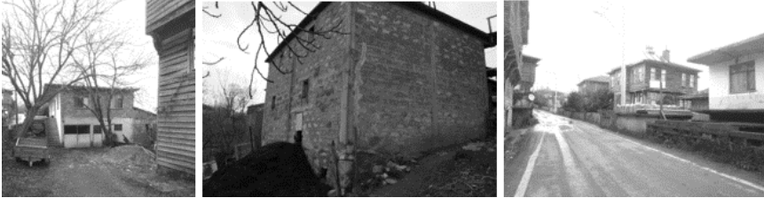
Şekil 17 Doku ile uyumsuz betonarme ek yapılar ve asfalt ile yol kotunun yükseltilmesi durumu
