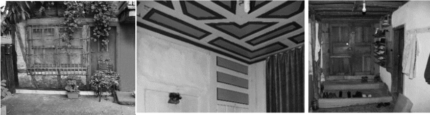
Şekil 13 RÇ evi yapım sistemi, profilli geometrik tavan ve bakkal tavan uygulaması
