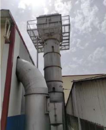
Şekil 13: Pres baca gazı ölçüm noktası
