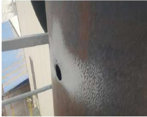
Şekil 14: Kazan dairesi baca gazı ölçüm noktası
