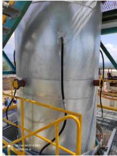
Şeki 15. Kurutma döner fırın baca gazı ölçüm noktası
