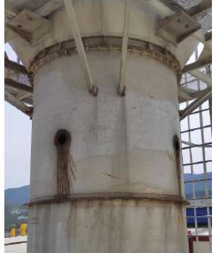
Şekil 13: Pres baca gazı ölçüm noktası
