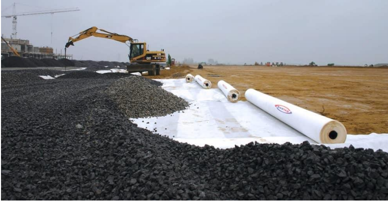
Şekil 2.1. Yol inşaatında geotekstil kullanımı
