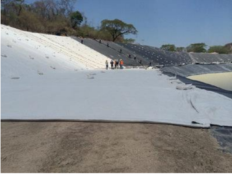
Şekil 2.8. Geosentetik kil astar
