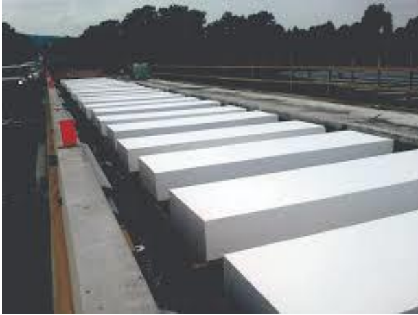
Őekil 2.6. Geofoamların dolgu malzemesi olarak kullanımı
