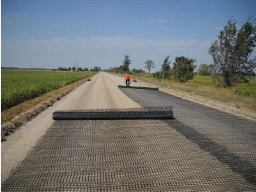
Şekil 2.3. Yol inşaatında geogrid kullanımı
