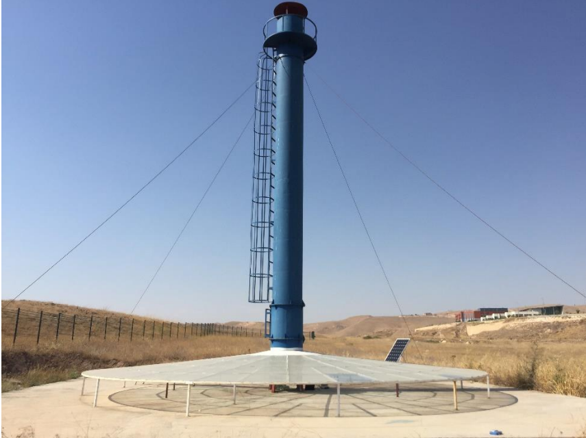
Şekil 1. Güneş Bacası Prototipi
