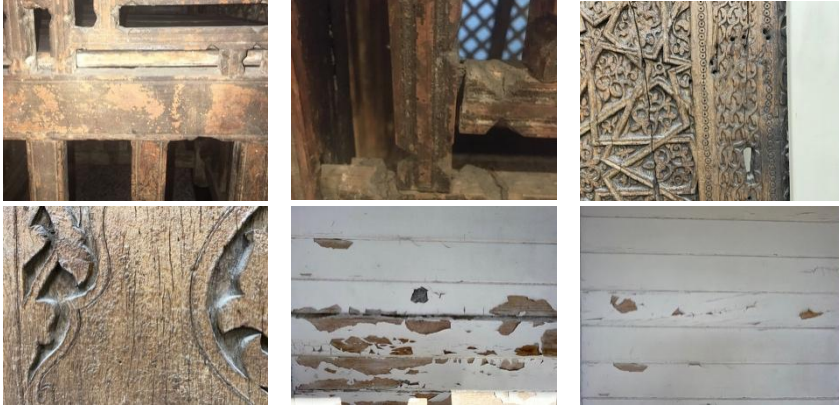
Resim 11 Eser yüzeyine uygulanan koruyucu katmanda tabakalaşma/ayrışma.
